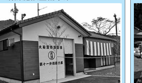
被災した全ての消防屯所の復旧が完了しました
