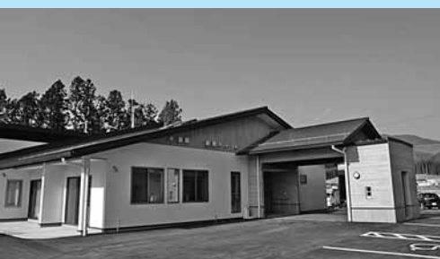
高台に建設された赤崎地区公民館は、4月1日から施設利用を開始しました
